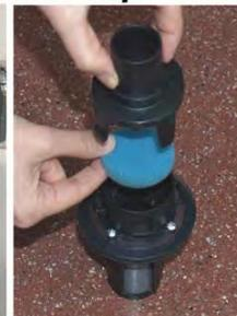
4. Den Filter kontrollieren. Falls er schmutzig ist, auswaschen, auswringen und wieder aufmontieren
