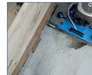
Gründliches Arbeiten an Kanten
