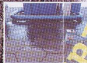
Entfernung von Diesel auf einer Tankstelle. Wirkzeit hier ca. 30 Min.
