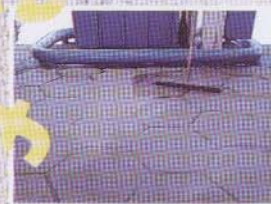
Entfernung von Diesel auf einer Tankstelle. Wirkzeit hier ca. 30 Min.
