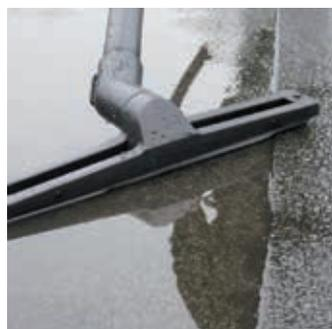
Die 360 mm breite Nassbodendüse im Einsatz auf dem Flachdach.
