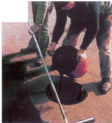
**Bitufix Porenfüllmasse** für Oberflächenversiegelungen rauher und poröser Asphaltbeläge.
