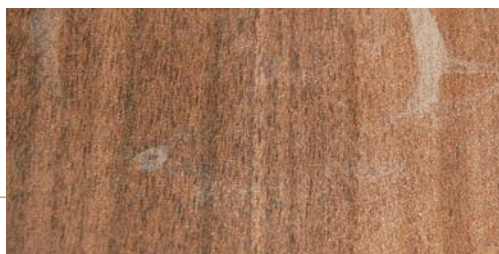
Laminatboden mit falscher Pflege: Schlieren, Trittsuren und leichte Aufquellungen.
