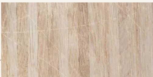
Versiegelter Holzboden ohne Pflege: stumpf, abgenutzt und verkratzt.
