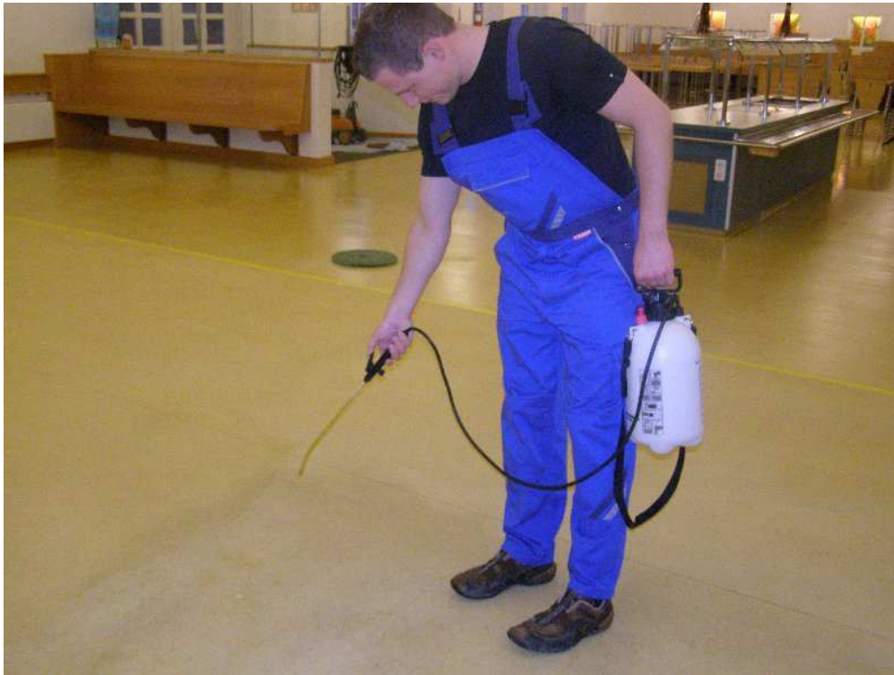
Abb. Grundreinigung mit Solex im Sprühverfahren
